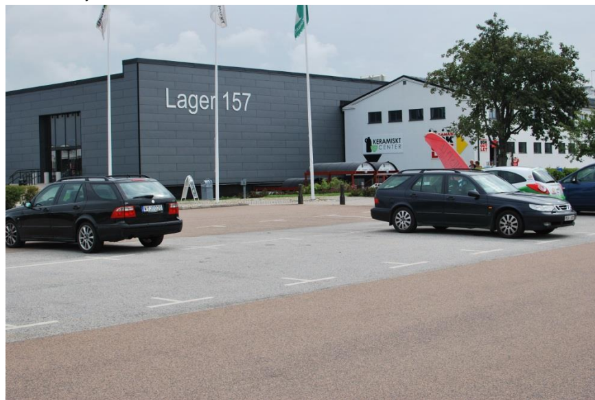
Figur 18: Entrén till Keramiskt center ligger i gamla fabriken till Höganäs Keramik, men kommer i skymundan av stora outlet-butiker.
